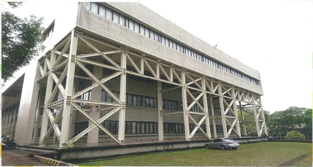
圖書館北面外觀現況
